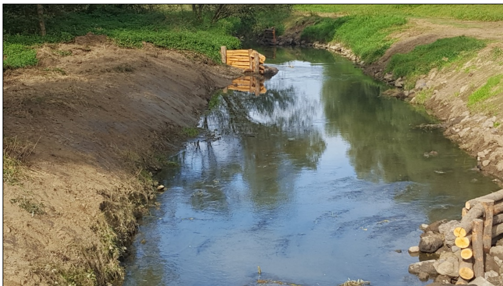
Slika 4: Inklinantni odbijači toka povečajo odtok vode pri nizkem stanju, pri visokem pa pospešijo odtok.
