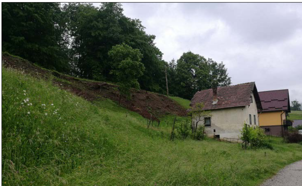
Slika 1: Zemeljski plaz se je sprožil, ker je bila na pobočju za hišama odstranjena vegetacija, ki je zadrževala zemljino.
