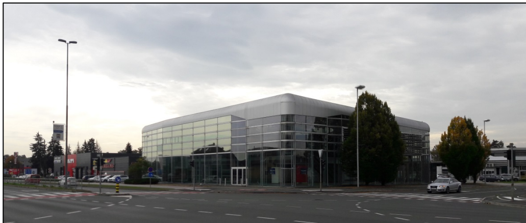
Slika 14: Moderni objekt zaradi materiala in umestitve na kraj, kjer se prometnica nekoliko zalomi proti jugojugovzhodu deluje kot vizualni poudarek.
