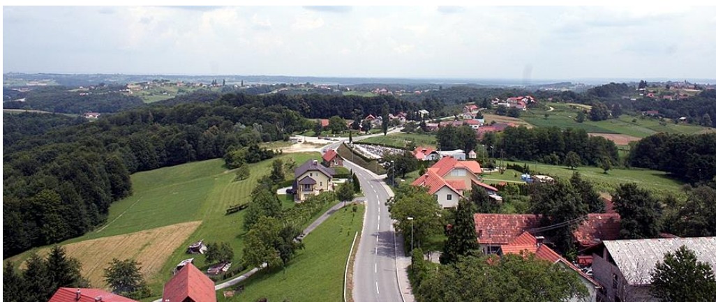
Slika 13: Pogled z gasilskega stolpa v Cerkevniku proti Kadrencem in Cogetincem. Poselitev in komunikacije so skoncentrirani na slemena. Na osojnih legah (levo od ceste) je delež gozdov višji. Ti segajo višje proti slemenom.
