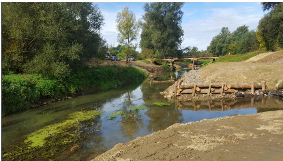
Slika 7: Zaliv v strugi Ščavnice in utrditev brežine proti poplavi.
